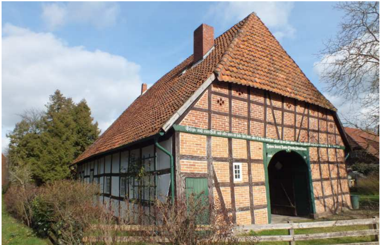
Das Haus in den 2010er Jahren (Fotos: Weigang)
