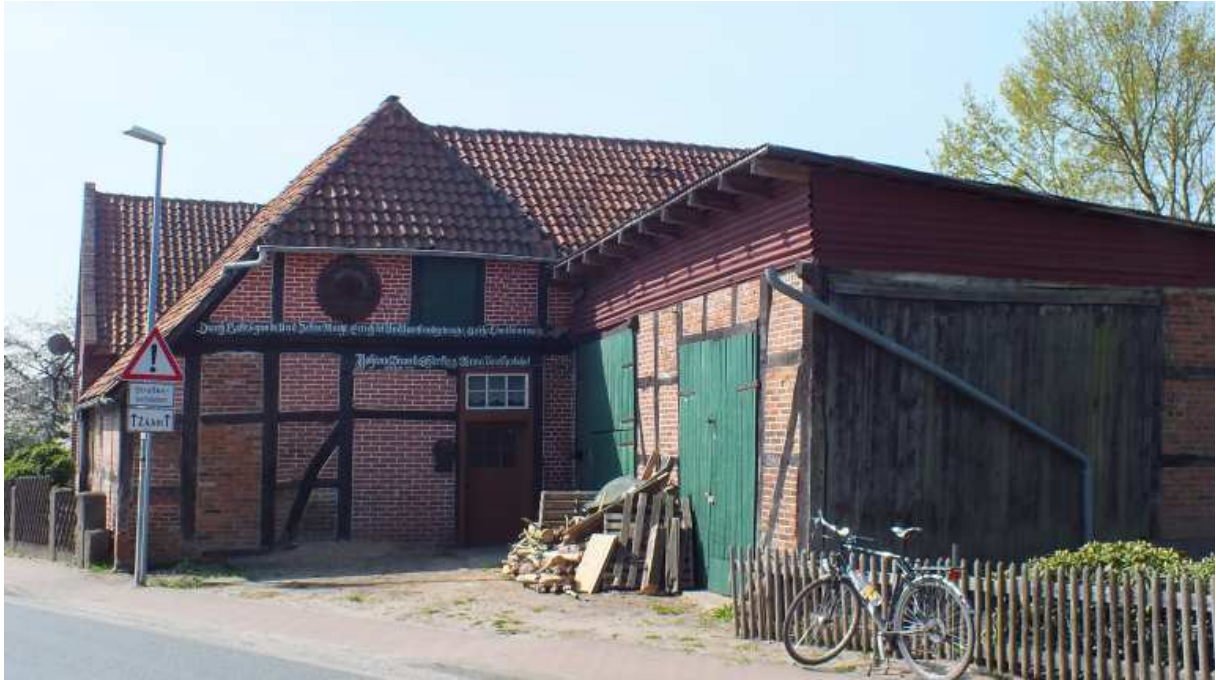
Der Hof in 2015 (Foto: Weingang)
