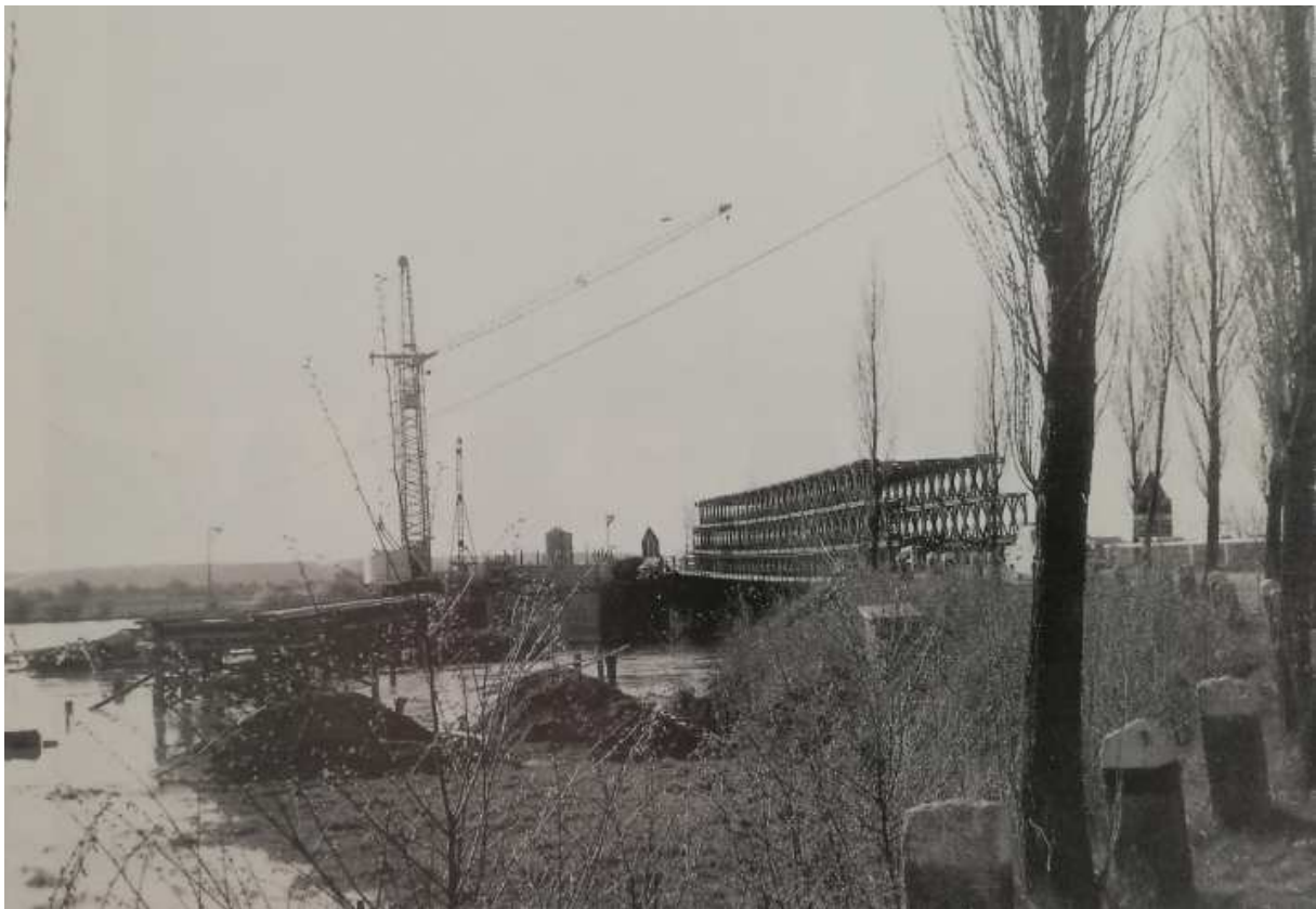
1959: Bau der heutigen Leine-Brücke
