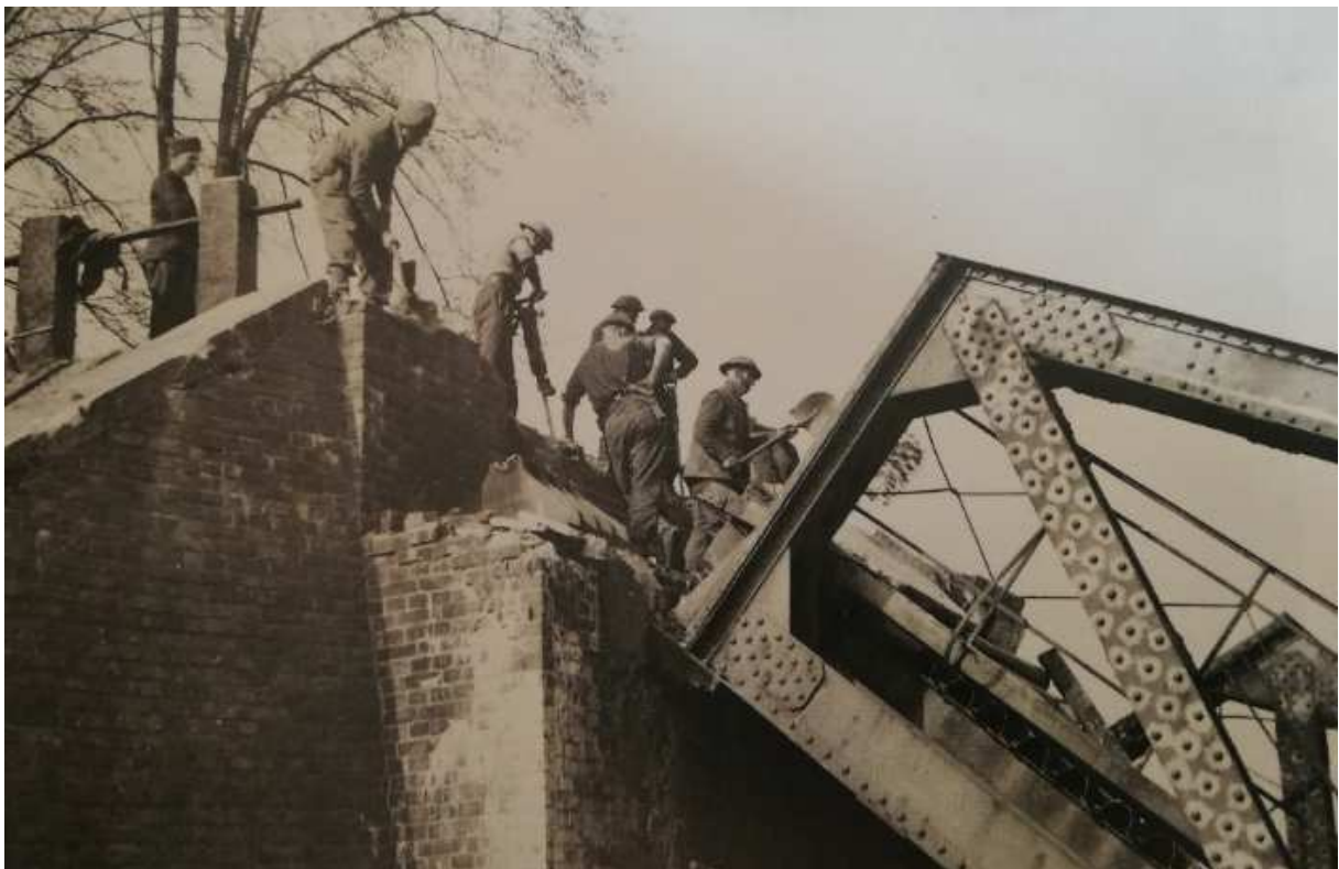
Die gesprengte Brücke
